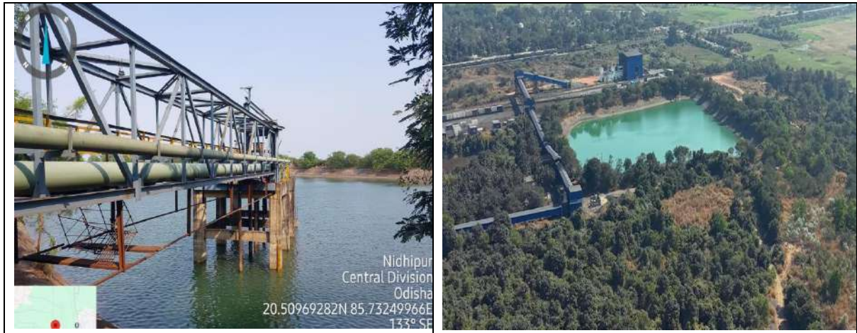
Figure: 11 (Water Reservoir)
