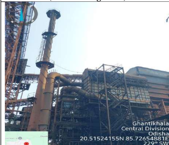
DRI T.H. (Stack & Baghouse)
